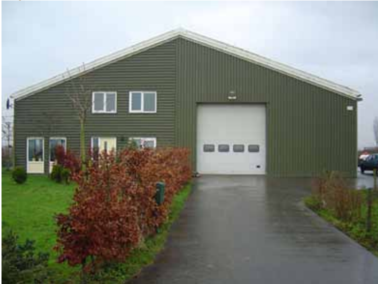
A woning in bestaande hal met andere richting van de gevelbekleding
