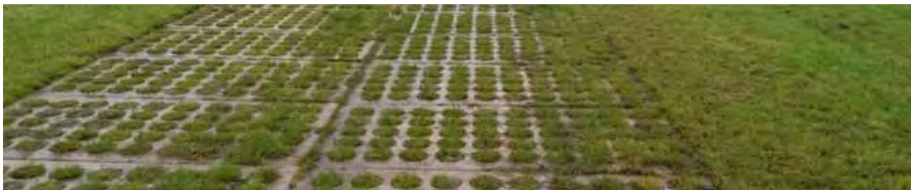
halfverharding waar mogelijk
