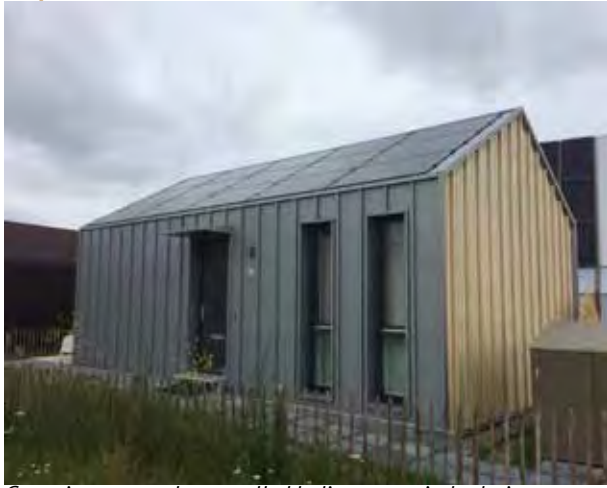
C woning met stalen gevelbekleding en typische huisvorm
