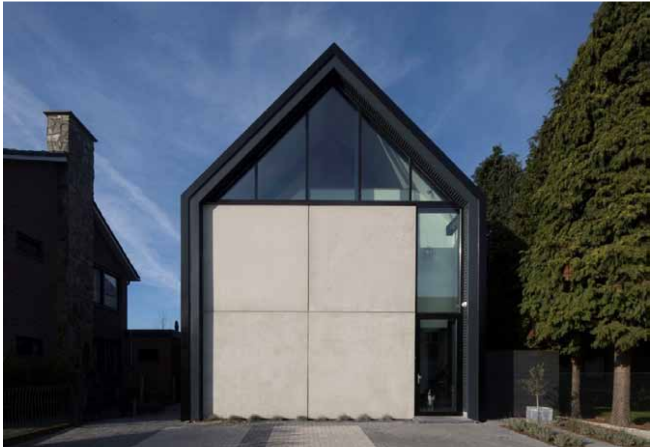
C woning naast bedrijfshal
